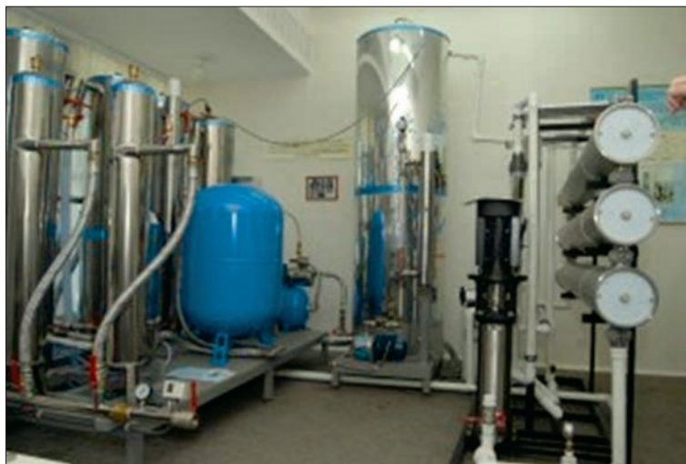
Багатофункціональна блочна установка з одержання питної води «Вега» для шкільних і дитячих закладів, підприємств харчового напрямку та закладів охорони здоров'я, житлових об'єктів, залізничного і водного транспорту
