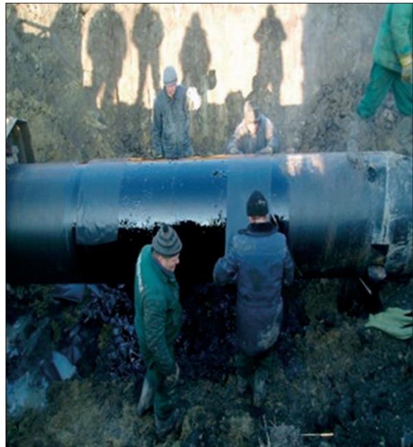
Термореактивний праймер для посилення антикорозійного захисту труб підземних трубопроводів, модифікації поверхні труби із залишками старого покриття в разі переізоляції трубопроводу бітумно-полімерними покриттями
