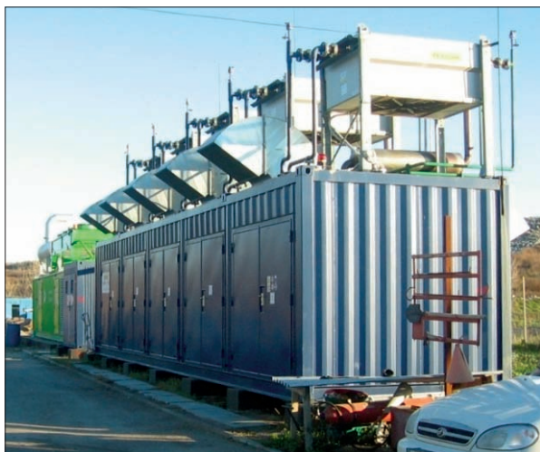
Станція для виробництва електроенергії з біогазу потужністю 1060 кВт на полігоні твердих побутових відходів в с. Підгірці Київської області, створена спільно з НВФ «ІНГАЗ». Інститут газу НАН України
