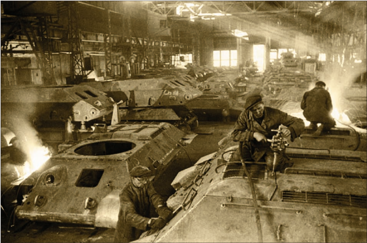
В одному з цехів заводу "Красное Сормово", де збирали танки з використанням технології зварювання під флюсом. Горький (нині – м. Нижній Новгород), 1942 – 1943 роки
