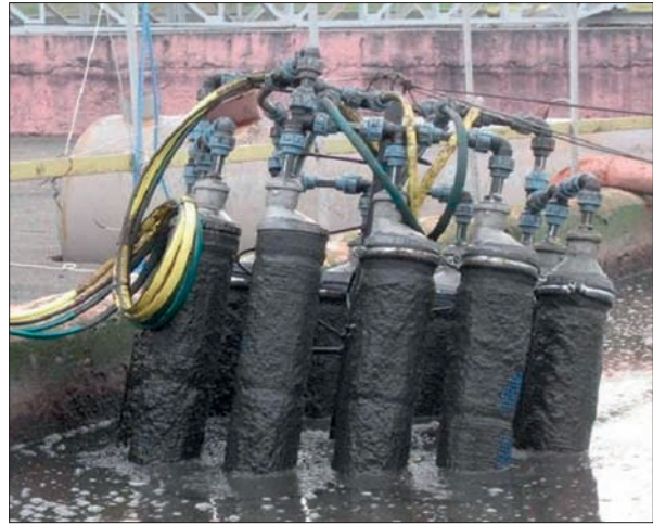
Технологія глибокого зневоднення осадів станцій аерації за допомогою контейнерних геотекстильних матеріалів: фільтрувальний модуль в аеробному стабілізаторі Бортницької станції аерації, Київ
